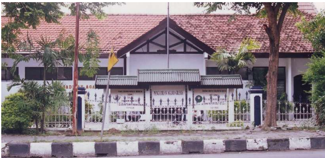
Gambar 1. 2 Bangunan Lama Gedung Pengadilan Agama Gresik
